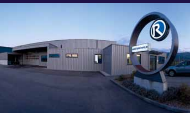
REINHART HYDROCLEANING SA FACTORY
