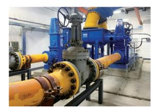
偏爱高含固率物料(危险废物、干污泥),适应流动性较好物料的高压远距离输送。
